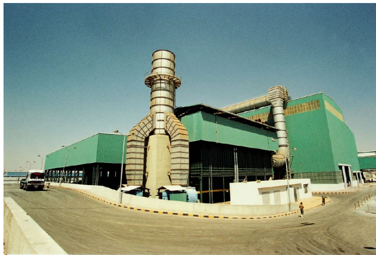
Система газоочистки на заводі Daniela, м. Удіне (10 км від Венеції)
