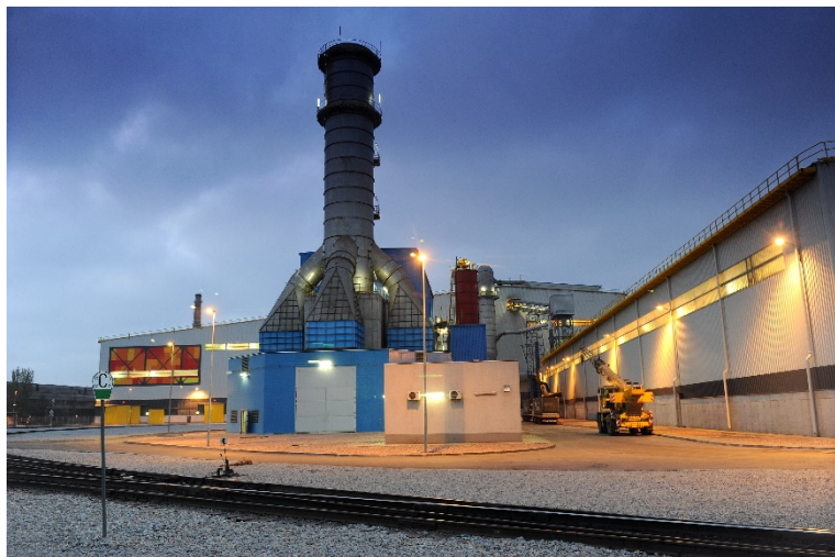
Система газоочистки на заводі ІНТЕРПАЙП СТАЛЬ, м. Дніпро
