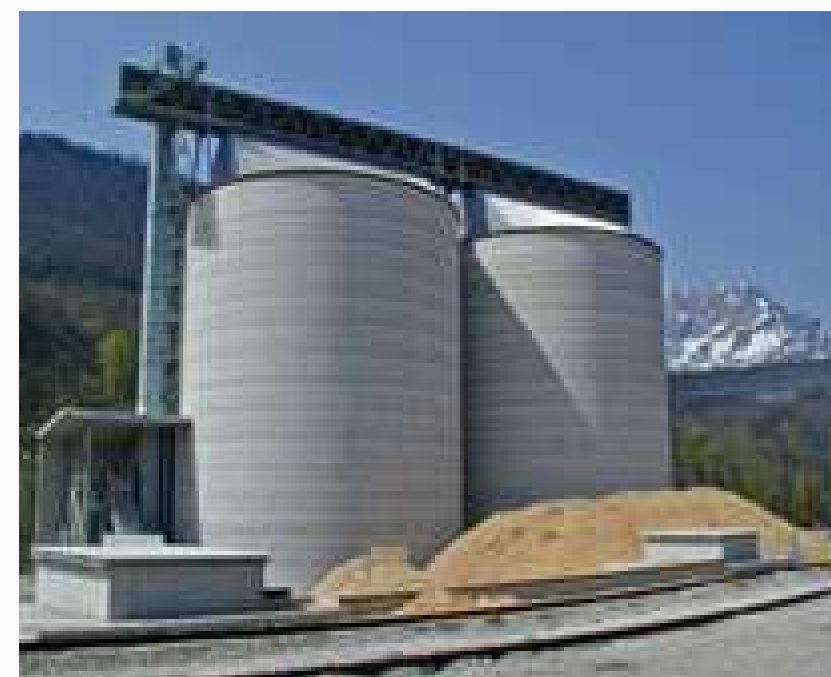
РЕЗЕРВУАРИ ПІД БІОМАСУ ТА ПІЛЕТИ
